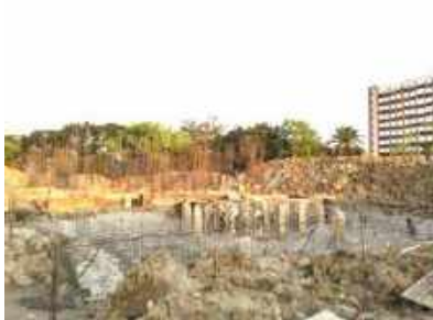
১০ তলা ভিতের উপর ১০ তলা পর্যন্ত ইন্সটিটিউট ভবন নির্মাণ
